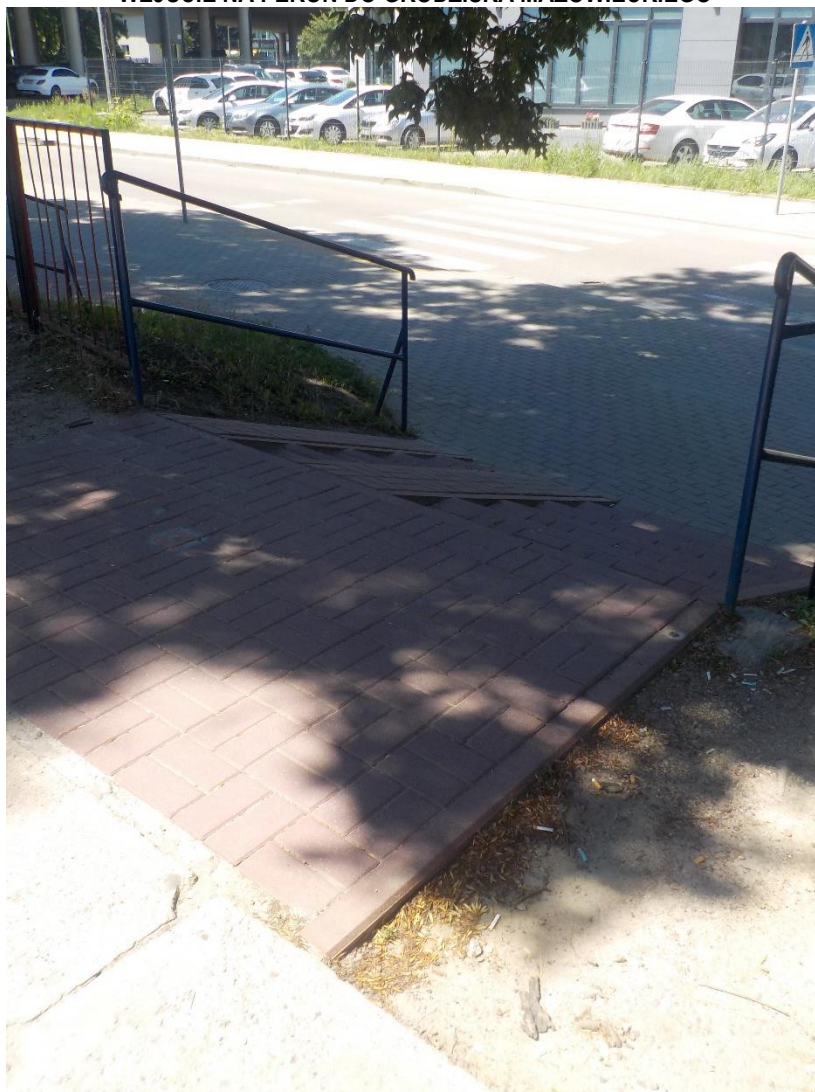
WEJŚCIE NA PERON DO GRODZISKA MAZOWIECKIEGO
