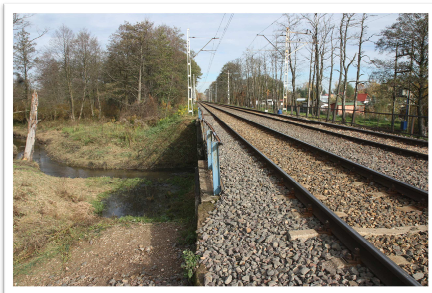
Fot.4 Widok na tor nr 1 od strony Grodziska
