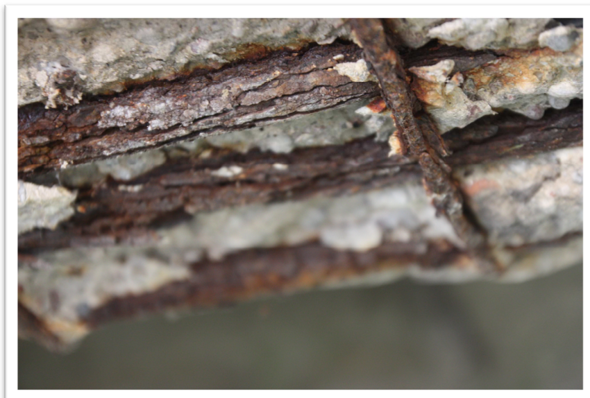
Fot.8 Skorodowane zbrojenie belek ustroju
