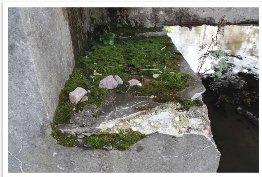
Fot.6 Widok z boku na przyczółek – uszkodzenia i korozja betonu
