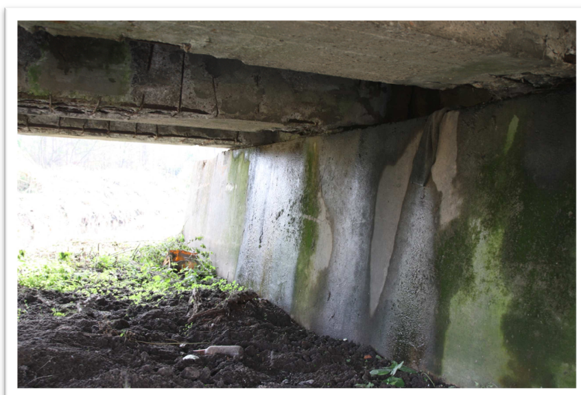
Fot.5 Widok od spodu konstrukcji – mokre plamy na pow. przyczółków
