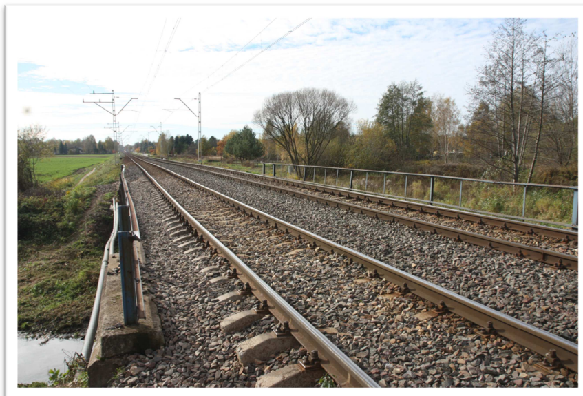
Fot.3 Widok z góry na tor nr 2 i nr 1 od strony Warszawy
