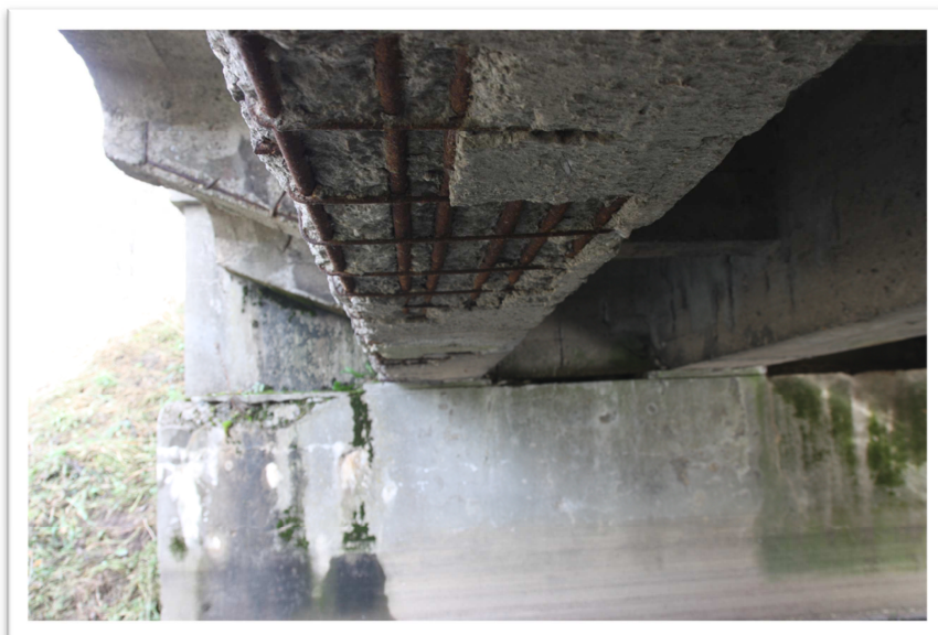
Fot.7 Widok od spodu konstrukcji – brak otuliny i skorodowane zbrojenie belek ustroju
