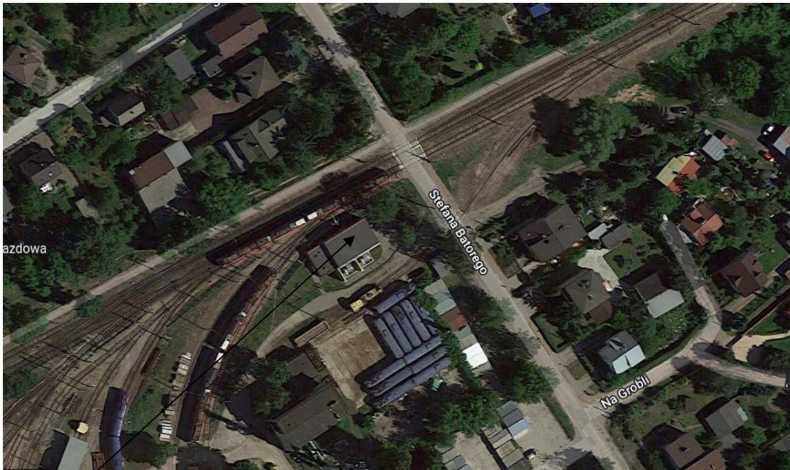
Budynek podstacji energetycznej Grodzisk Mazowiecki ul. Stefana Batorego 23
