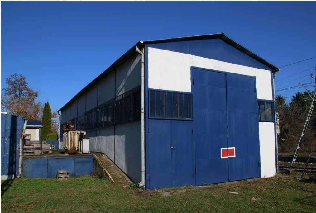
Hangar pociągu sieciowego
